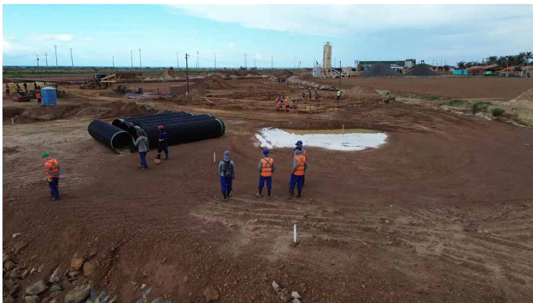
Figura 5 - Obras de Urbanização do Terminal Pesqueiro
